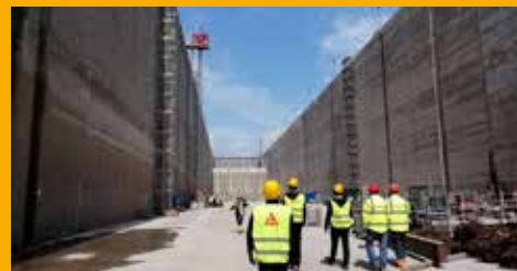
OPRAVA A OCHRANA BETÓNU
